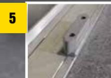
Le rail bas du sol peut être fixé sur le plancher existant – facile à installer et aucun d'entretien requis.
